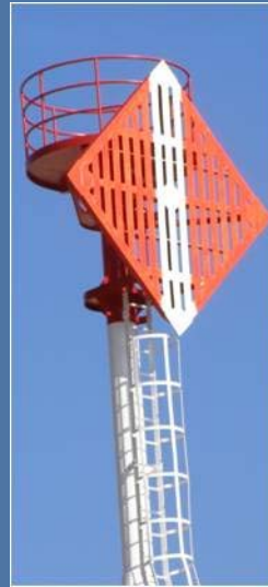
Svjetleće i signalne oznake pokrivenog smjera
